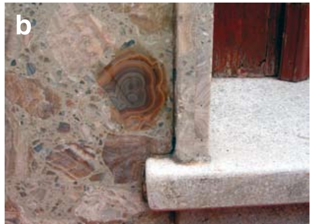
Foto 12: a) Imatge de la façana d'una casa de Ciutadella en la que va esser utilitzat el material extret de la cova des Màrmol. b) Detall d'una façana en la qual s'aprecien els fragments de formacions estalagmítiques extretes de la cova des Màrmol.
