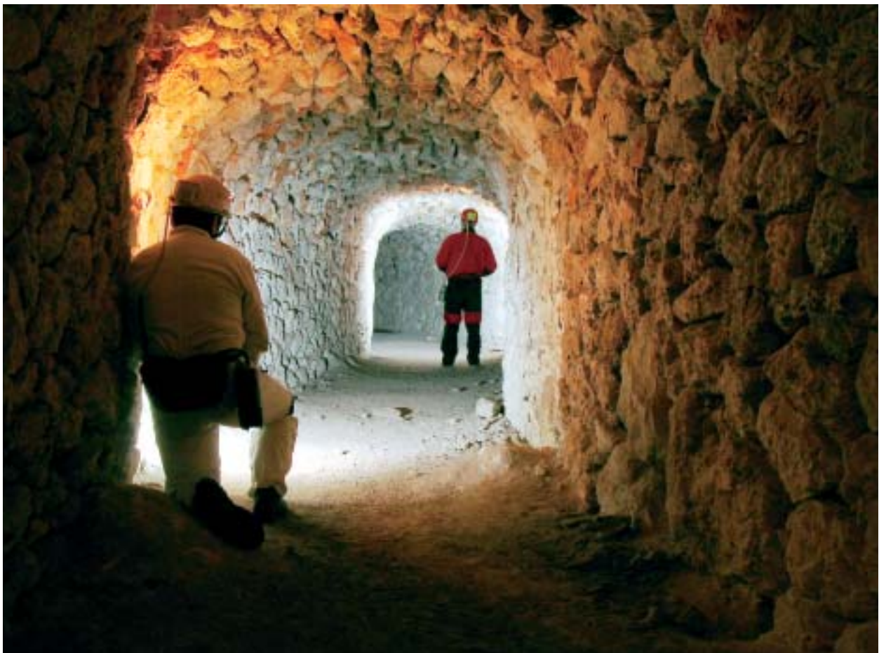
Foto 7. Galeria del Pilar (mines de guix de les coves del Pilar). Aquesta galeria empedrada va per davall de la sala Caverna des Caos (coves des Pilar) i té una longitud de 75 m des de la sala des Pilar. (Foto G. Santandreu).
